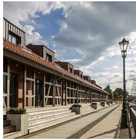
Dangės krantinės (Klaipėda)
